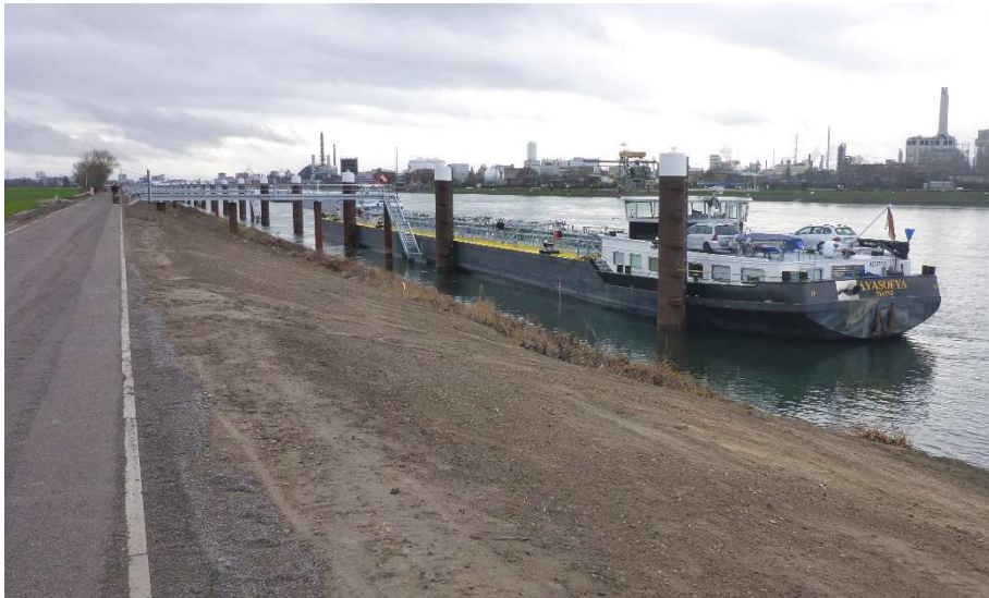
Abbildung 3: Instandgesetzter Uferweg (Bildquelle WSA Oberrhein)
