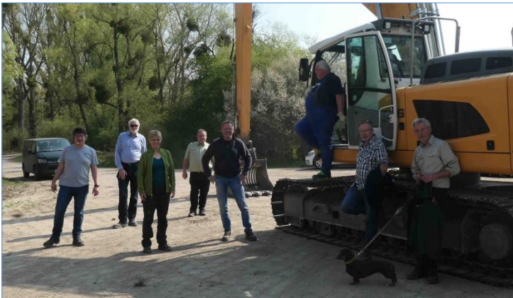
Team „Uferrückbau“ vor Ort
