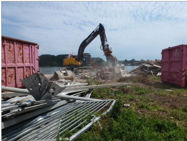
Während des Rückbaus
